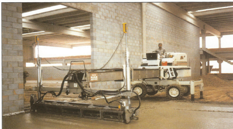
Figura 9.3: Equipamento Laser Screed
