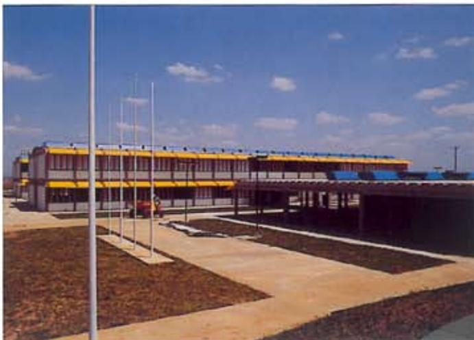
**Fig. 4- Edifício escolar de elementos pré-fabricados de argamassa armada**
