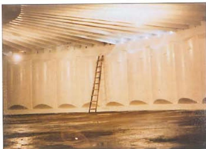
**Fig. 21 - Vista interna de um reservatório de parede ondulada, para 2.700 m<sup>3</sup> de água**
