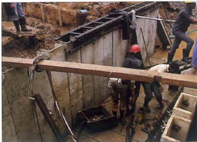
**Fig. 10 - Montagem dos elementos de canal de drenagem**
