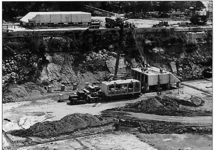
**Fig. 8 - Transporte e montagem dos segmentos pré-moldados da barcaça em dique seco**
