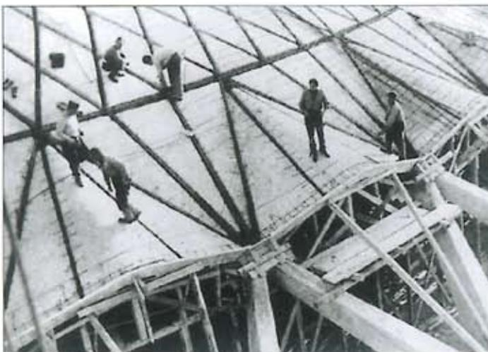
**Fig. 24 - Vista dos elementos pré-moldados já posicionados para concretagem das nervuras**
