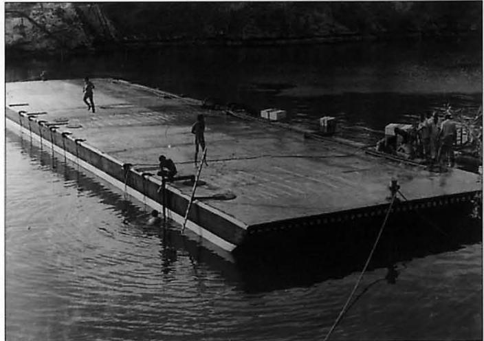
**Fig. 7- Barcaça de transporte marítimo e fluvial, de dimensões 30 m x 9 m x 3 m, construída em Cuba**
