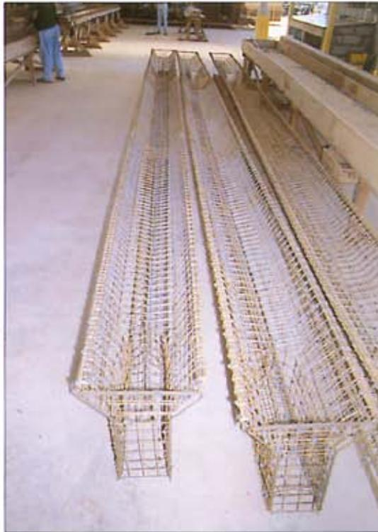
**Fig. 5 - Armadura pré-montada de uma viga-calha**
