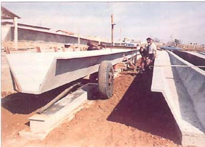
**Fig. 3 - Vigas pré-moldadas de argamassa armada no canteiro**
