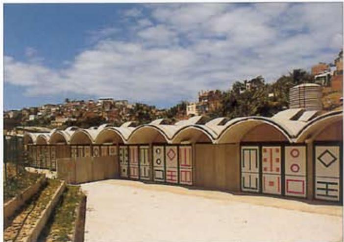
**Fig. 12- Creche com cobertura de abóbadas pré-fabricadas**
