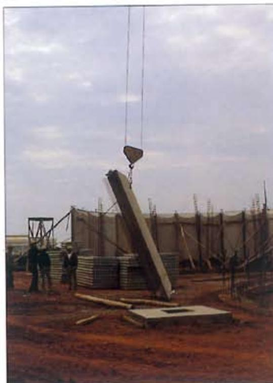
**Fig. 20 - Reservatório de parede ondulada, para 900 m<sup>3</sup> de água**
