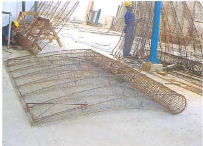
Figura 4.1 - Arranjo típico de armaduras de uma peça de argamassa armada
