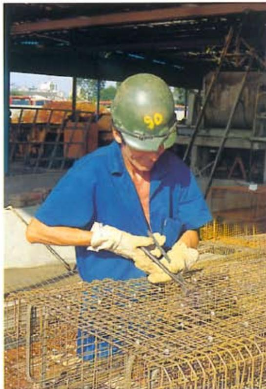
**Figura 4.5 - Espaçadores para garantia do cobrimento**
