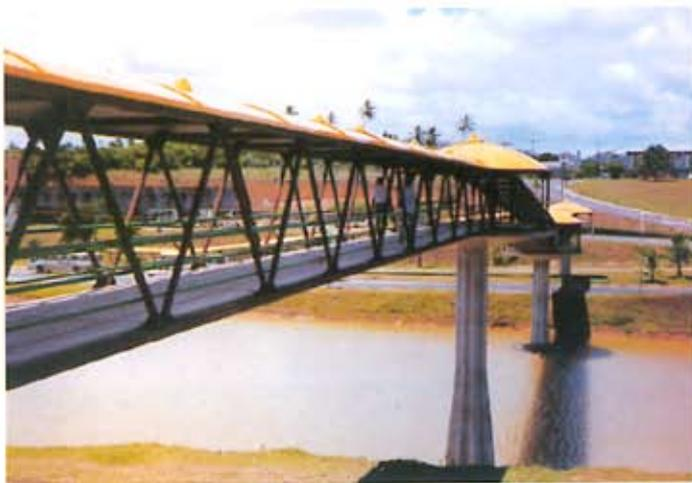
Figura 3.12 - Passarelas para pedestres em estrutura de aço, com elementos de piso e cobertura de argamassa armada
