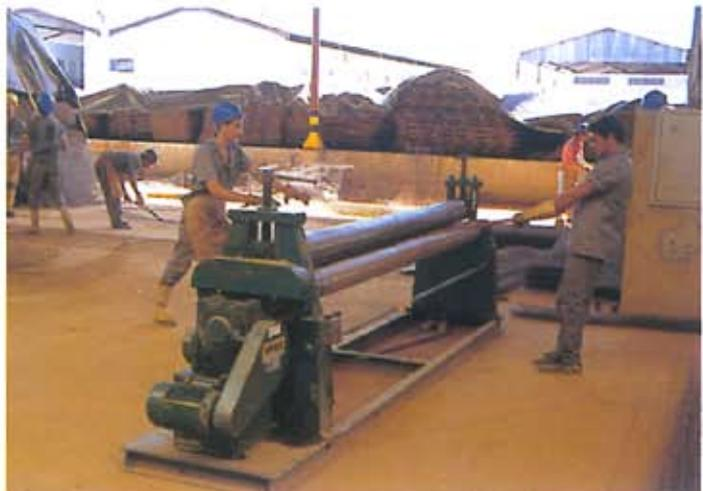
Figura 4.3 - Retificação das telas soldadas através do uso de calandras
