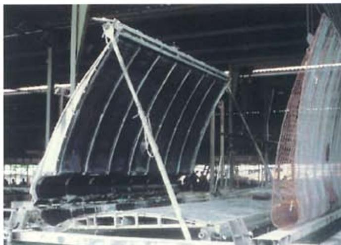
Figura 4.14 - Fôrma isolada para cobertura de abrigo de ônibus
