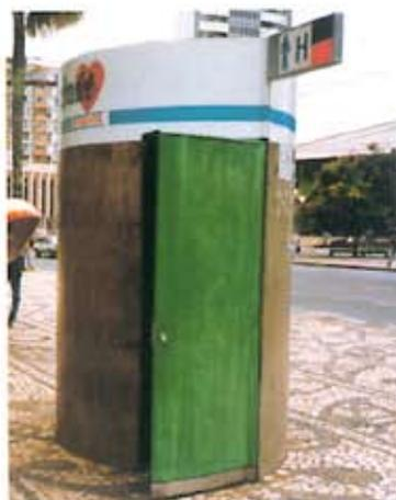
Figura 3.13 - Módulo sanitário em argamassa armada
