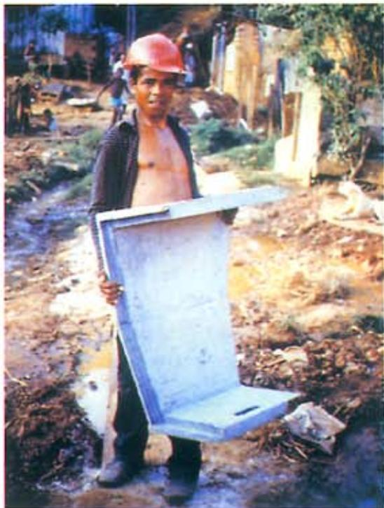
Figura 3.7 - Transporte e montagem manuais dos componentes
