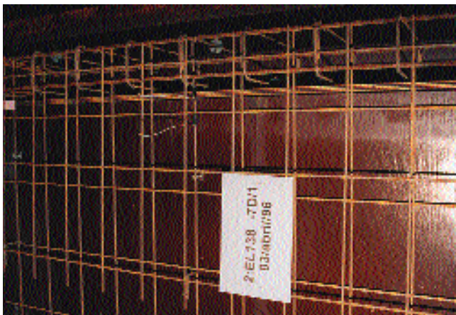
Foto 06.06 - Detalhe da região instrumentada da armadura: pontos 10 e 11
