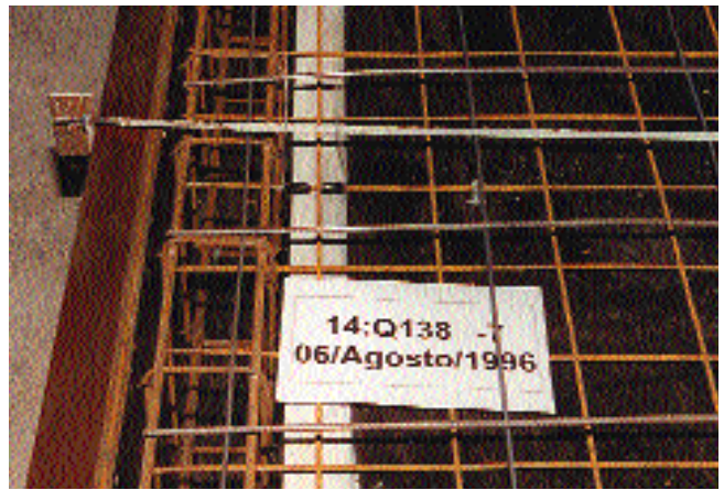
Foto 06.15 - Detalhe da região instrumentada da armadura: pontos 1 e 2
