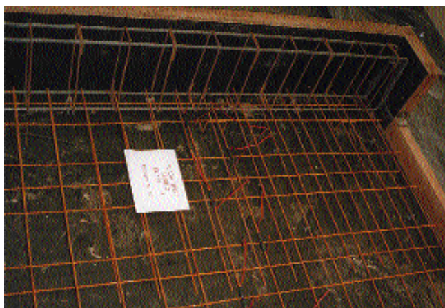
Foto 06.33 - Vista da armadura da região da viga de extremidade
