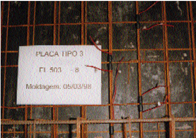
Foto 06.35 - Detalhe da armadura e da instrumentação da região da viga de extremidade
