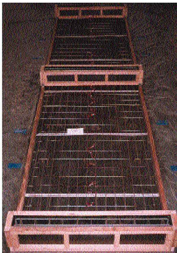
Foto 06.34- Fôrma do modelo 3 com armadura posicionada
