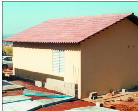
O sistema de construção com concreto celular prevê inicialmente a execução de uma laje monolítica, tipo radier, que funcionará como base de trabalho para a montagem das fôrmas e instalações. As fôrmas, que são a base desse processo construtivo e podem ser reutilizadas centenas de vezes, são constituídas por painéis de chapa de madeira, revestidos com filme de grande resistência, estruturados em perfis metálicos tubulares. O encaixe é feito por grampos metálicos especiais. Uma vez preparadas as
