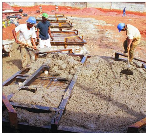
para fabricação de lajes, que devem ser moldadas no local mais próximo possível de onde elas serão utilizadas. Posteriormente, as lajes são içadas e posicionadas no local definitivo e em seguida faz-se o grauteamento entre a união de lajes. Imediatamente, já é possível trabalhar em cima da laje.
