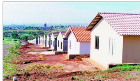
tema de tratamento de esgoto, galerias multiuso, coleta de lixo seletiva e pavimento intertravado. As casas são construídas em concreto celular a custos acessíveis à população de baixa renda. As paredes são produzidas em fôrmas, já embutindo janelas, portas, instalações elétricas e hidráulicas, o que agiliza o processo construtivo.
